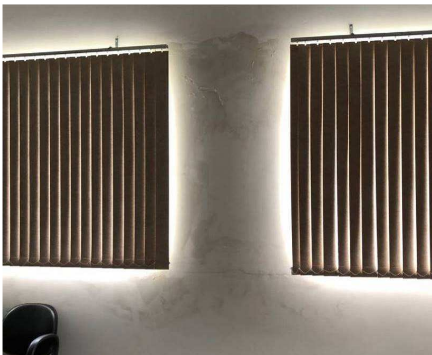
Foto 11 - Janelas da sala de audiência com infiltrações, onde o revestimento das paredes deverá ser refeito
