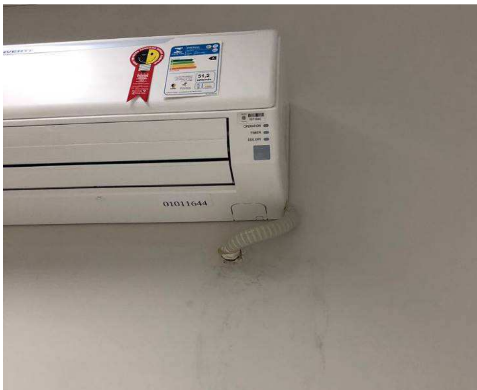
Foto 13 - Infiltração causada pelo dreno de ar condicionado
