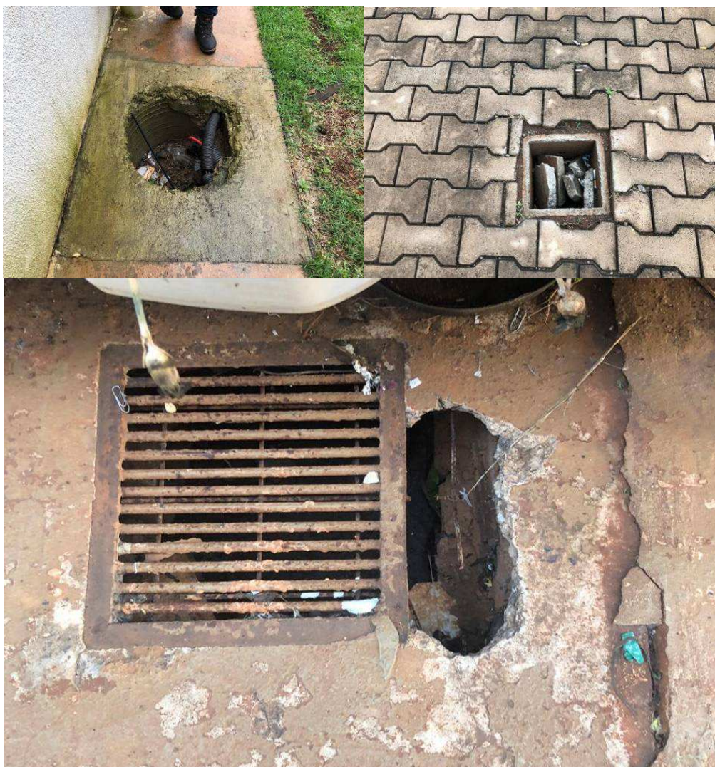
Foto 16 - Caixas de passagem danificadas
