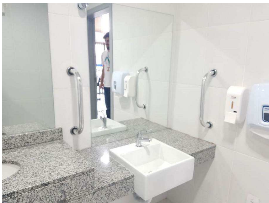
Imagem 15 - Lavatório acessível executado no Fórum Eleitoral de Araucária
