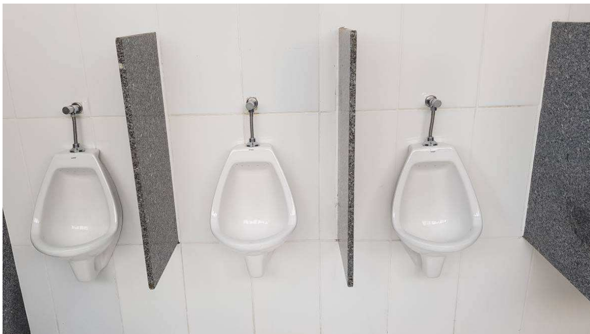
Foto 8 - Mictórios do Fórum Eleitoral, sem acessibilidade, necessária a instalação das barras de apoio, além do remanejo para atender às medidas e distancias apresentadas pela norma NBR 9050
