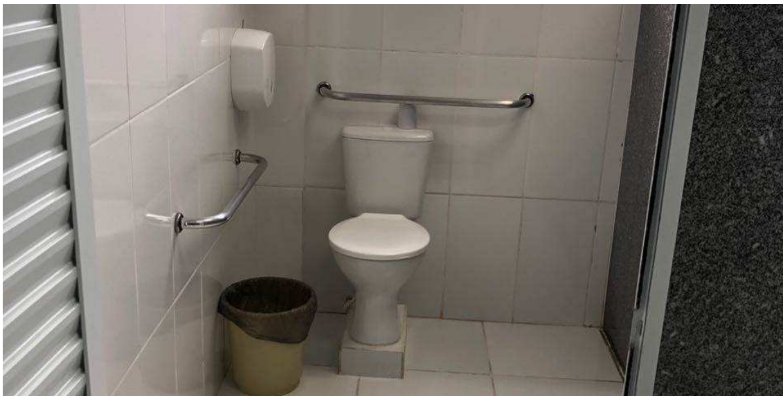
Foto 6 - Bacia sanitária do Fórum Eleitoral, onde é preciso a remoção e reinstalação das barras e da bacia na altura apresentada pela NBR 9050
