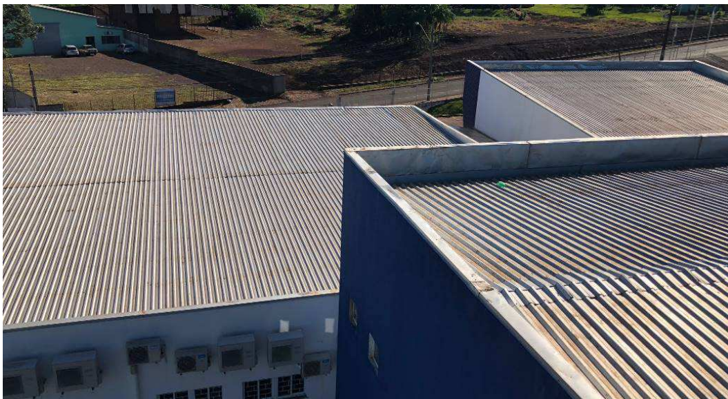
Foto 10 - Coberturas, sobre as quais deverá ser instalada manta asfáltica aluminizada, inclusive sobre a platibanda e sob o rufo. O rufo deverá ser substituído por um novo
