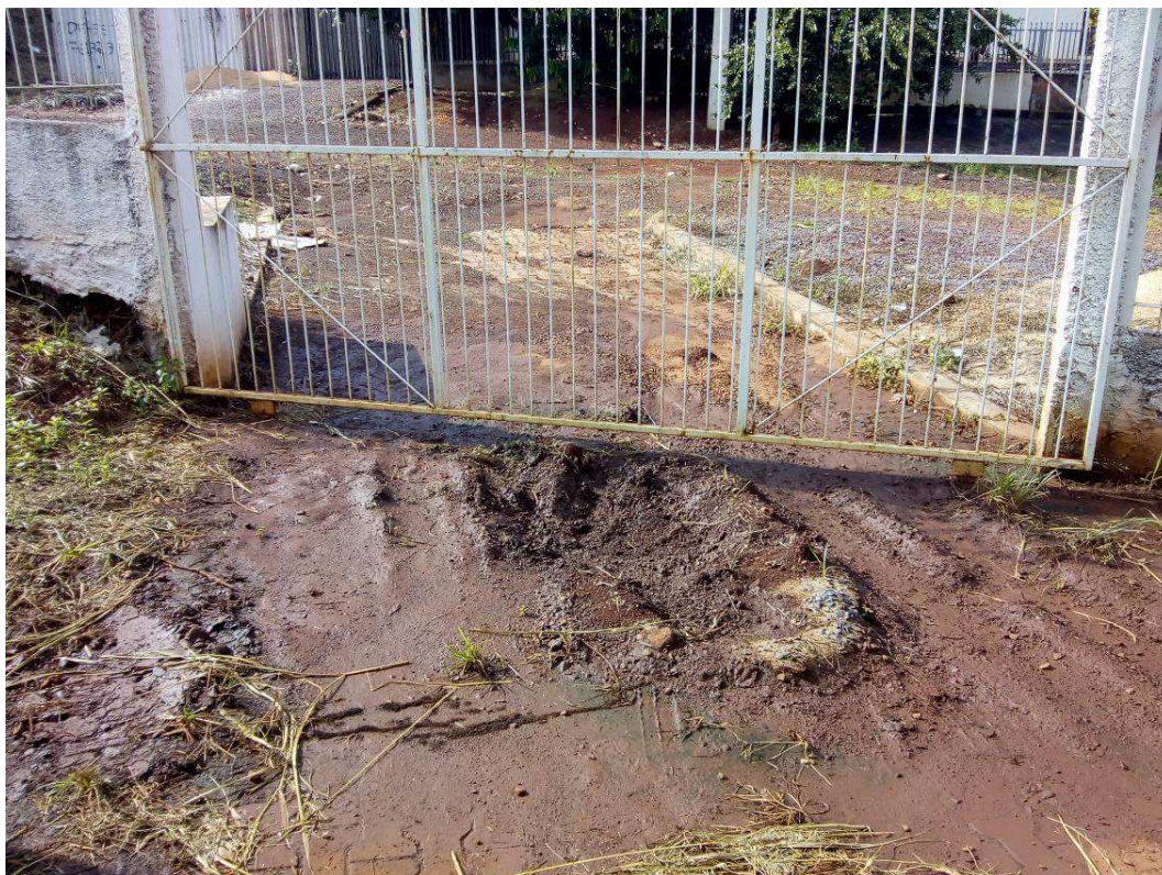
Foto 15 - Portão de acesso ao terreno, onde se faz necessária a execução de nova viga baldrame com trilho, para reinstalação
