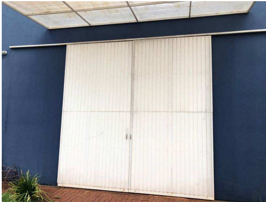
Foto 15 - Portão de acesso ao terreno, onde se faz necessária a execução de nova viga baldrame com trilho, para reinstalação
